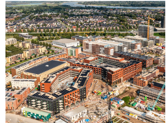
Dronebeeld constructie Donk en Elft © Diego Rosero
